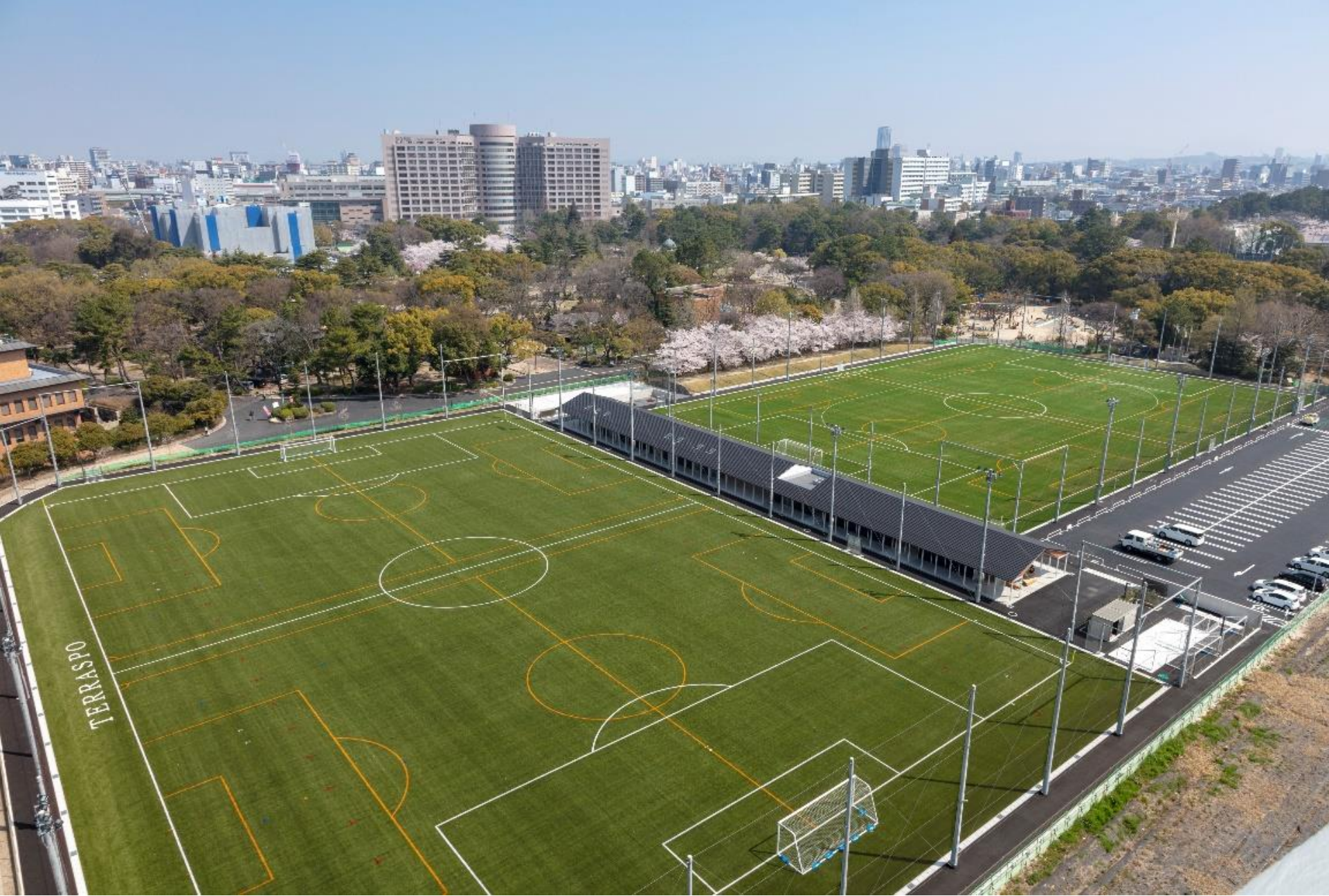
施設全景・工事中の公会堂や名古屋大学附属病院を望む
